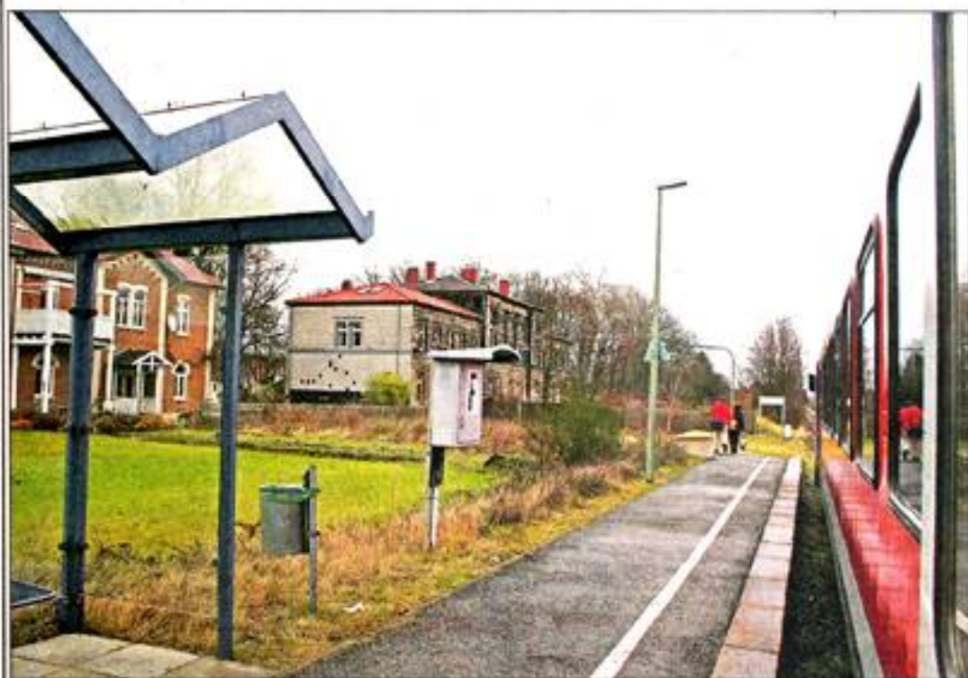
So sah der Jerzheimer Bahnhof noch vor drei Jahren aus. Das Foto entstand wenige Tage vor der Aufgabe der Bahnstrecke zwischen Schöppenstedt und Helmstedt. Archivfoto: nj
